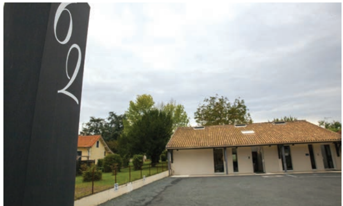
Sur près de 250 m 2 , le cabinet a été entièrement conçu pour le confort des patients. Proposer un parking privatif en fait partie.
